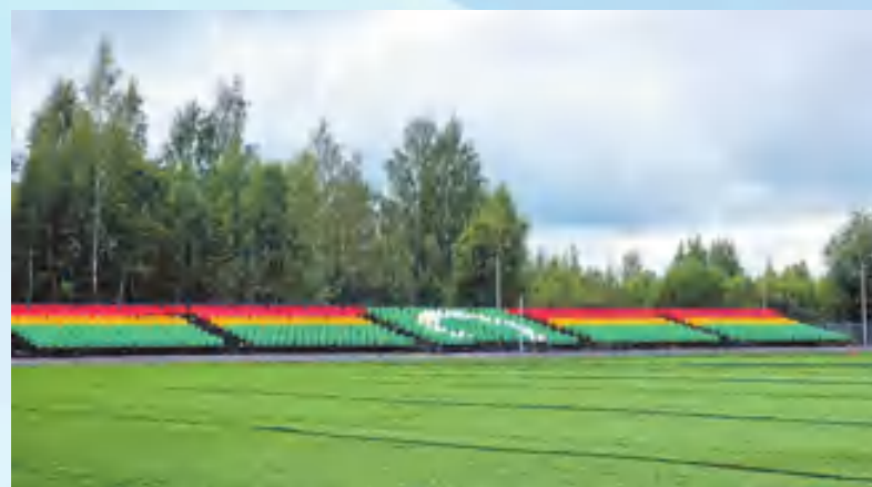
В Тосно полным ходом идёт ремонт социальных и спортивных объектов
